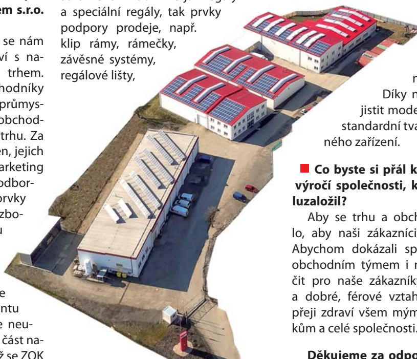
Výrobní a skladové prostory ZOK v Havlíčkově Brodě.
